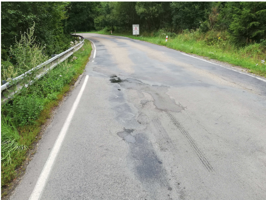
Foto č.15 - Pohled na průsak spodní vody ve vozovce za mostem – proti směru staničení
